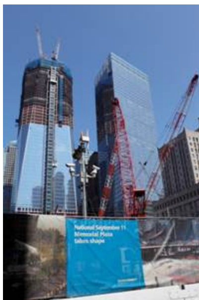
Aço Gerdau presente nas obras do novo World Trade Center Crédito: Arquivo Gerdau
